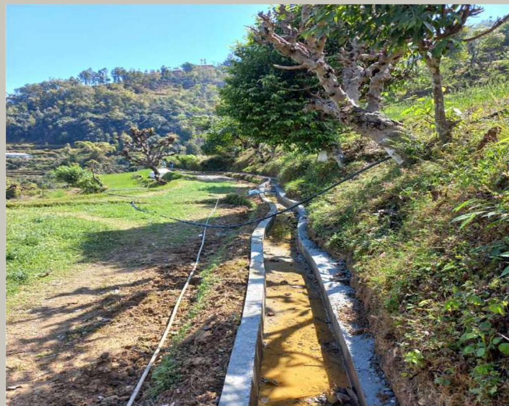
काउलेखोला डुमीखर्क सिंचाई कुलो मर्मत
