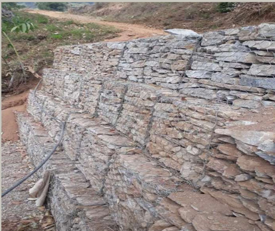
ग्याबियन पर्खाल (खन्यारुख लोलेन्खोला सडक )
